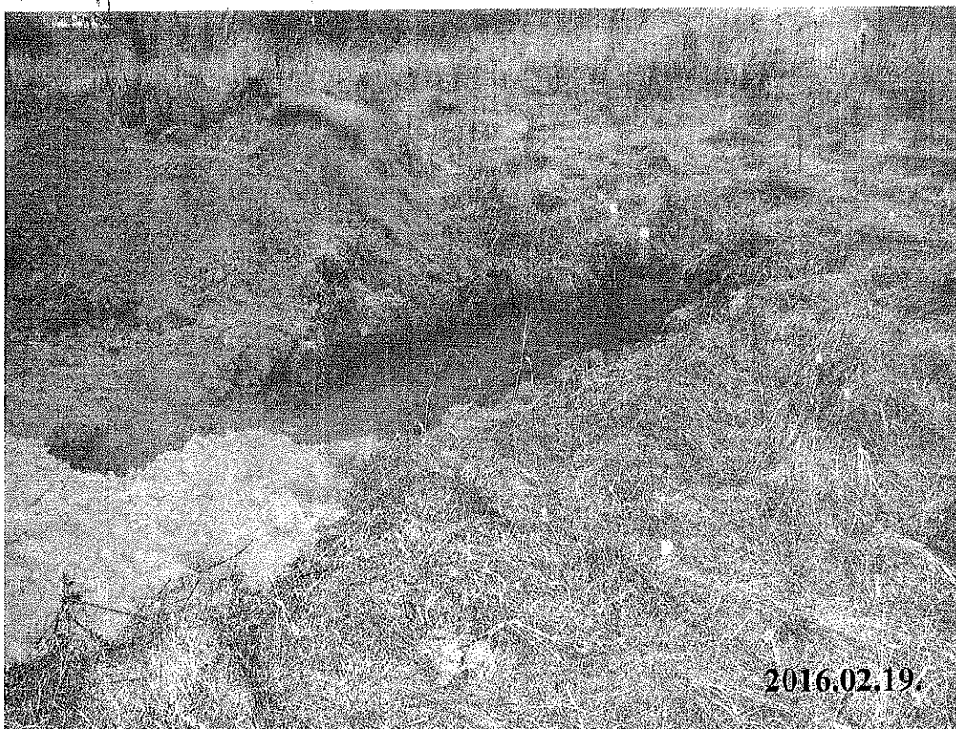
1. számú kép: kutatóárok készítése
