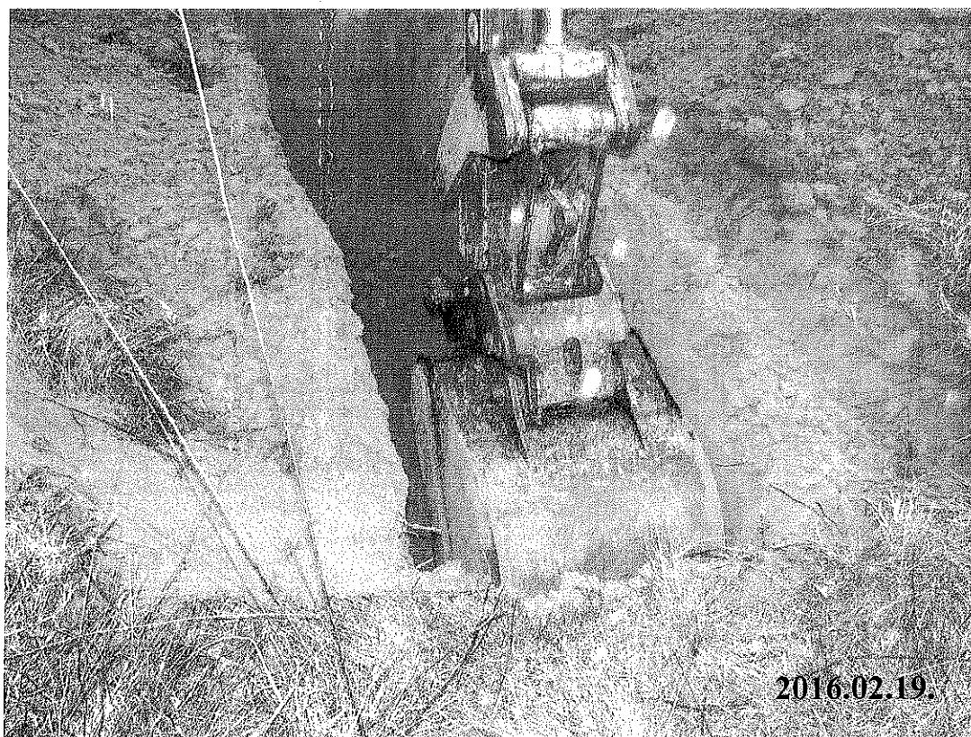
6. számú kép: kutatóárok készítése
